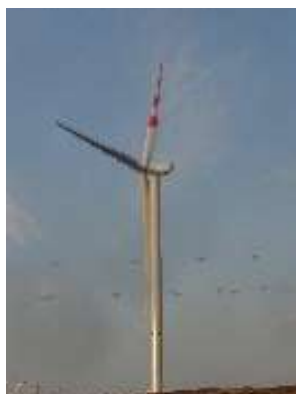
Fotografía 1. Ejemplo de palas pintadas con cuatro bandas rojas en una de las palas del aerogenerador.
